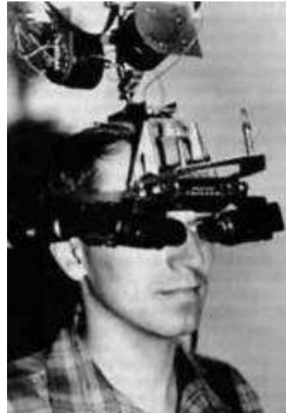
Fotografía del dispositivo Head-Mounted-Display, 1968 de Iván Sutherland 75
